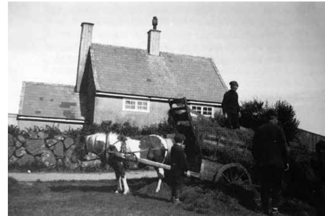
Cellan. Í tí lægra bygninginum var vaktarstova og náttúð.
